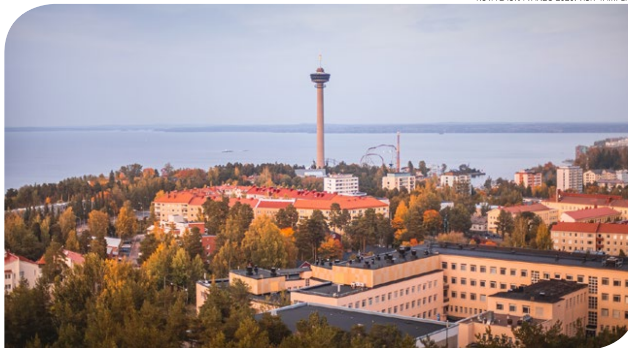
Pirkankadun länsipää on maakunnallisesti arvokasta kulttuuriympäristöä. Etualalla Pynnikin ammattikoulu, joka oli ensimmäinen ammattikoululle suunniteltu rakennus Suomessa.
